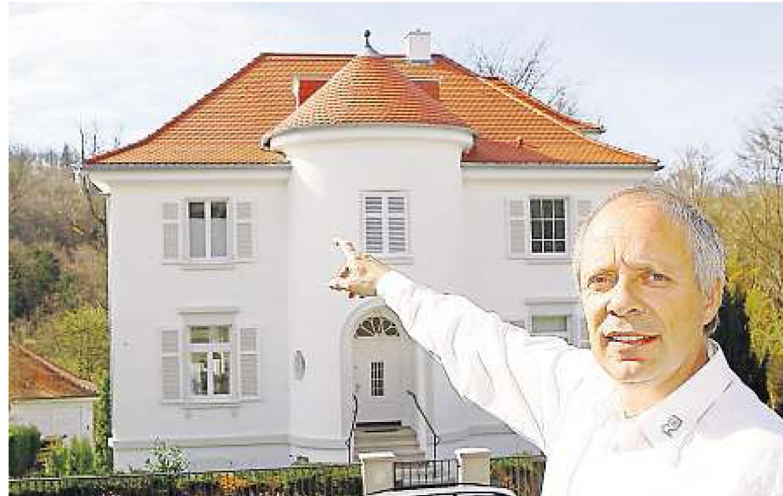
Preisverdächtig: Diese Villa an der Friedenstraße kann sich sehen lassen. Markant ist der Kegelturm samt Unterkonstruktion, den Ulrich Senn sanierte. FOTO: KETTERL
