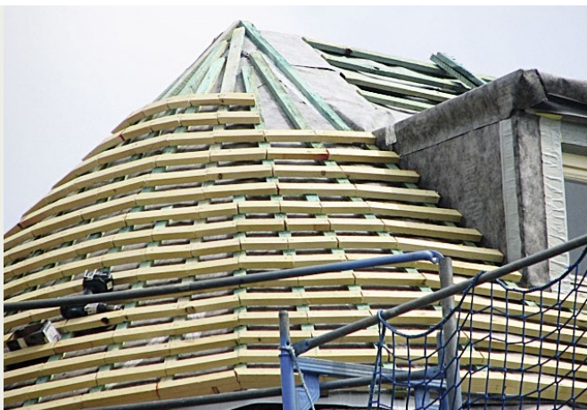
Aus hunderten Segmenten erstellten die Dachdecker die Traglattung für die Biberschwanzdeckung.
