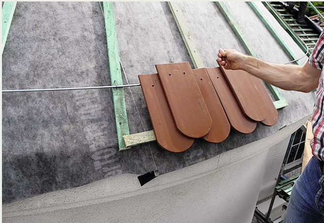
Für das Anlegen der ersten Latten benutzten die Dachdecker einen Blitzschutzdraht, um so den „richtigen Bogen“ rauszubekommen.
