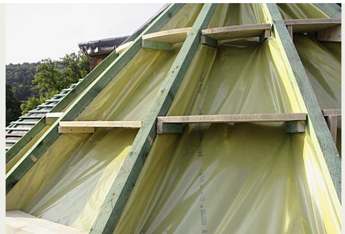
Vor der Vollschalung folgte die energetische Ertüchtigung mit 200 mm Minerldämmung und geschweiften Dampfbremse.
